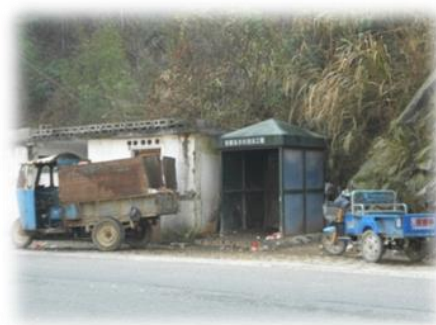
图7 汤口镇冈村垃圾池
